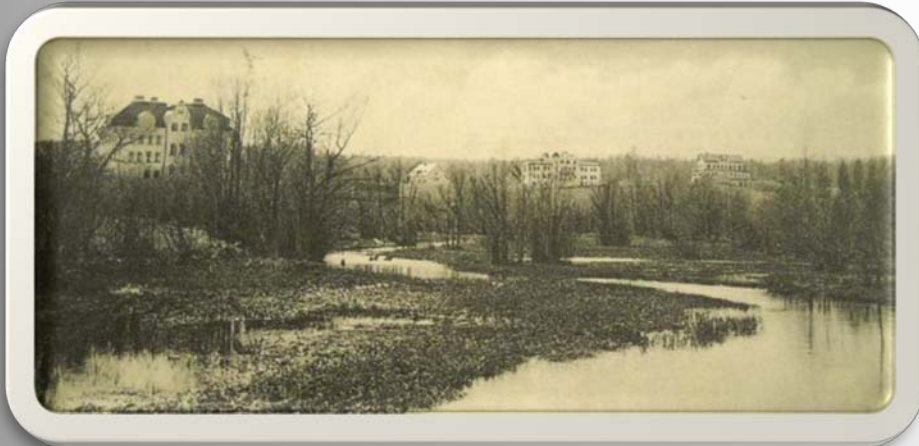
2 Svartevadsbäcken var betydligt bredare och mäktigare 1910. "Borgen" byggdes som privatbostad 1902 under namn "Villa Epstein"
